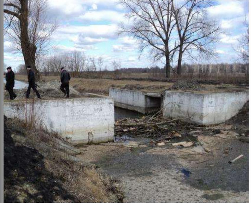
Стан осушувально-зволожувальної системи «Смолянка» до початку ремонтних робіт
